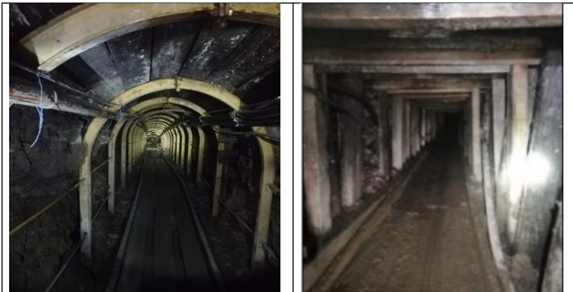
Fotografía 1.8. Fortificación de la bocamina
