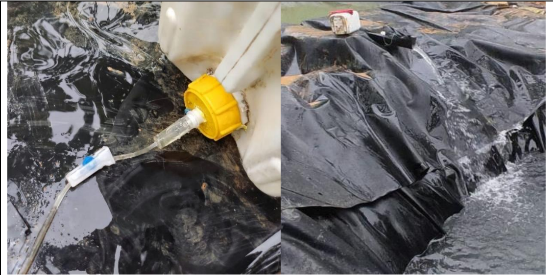
Fotografía 1.56. Sistema de dosificación y mezcla de coagulante
