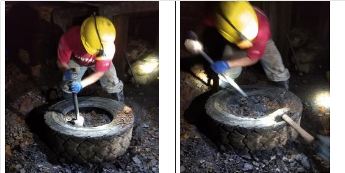
Fotografía 1.13. Relleno y pisoneado de aglomerado
