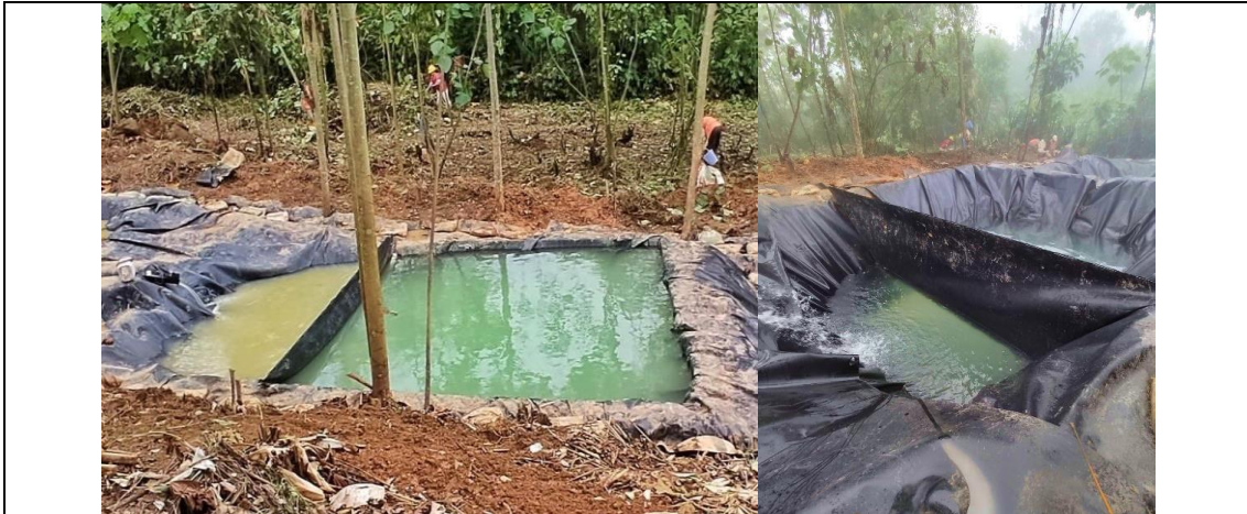
Fotografía 1.57. Piscina para coagulación de efluente de interior mina
