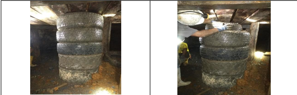
Fotografía 1.15. Colocación de tercer o cuarto neumático
