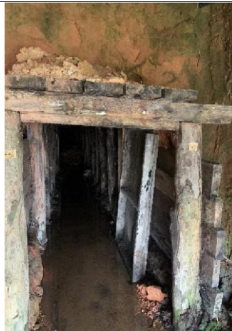
Fotografía 1.74. Túnel de mina
