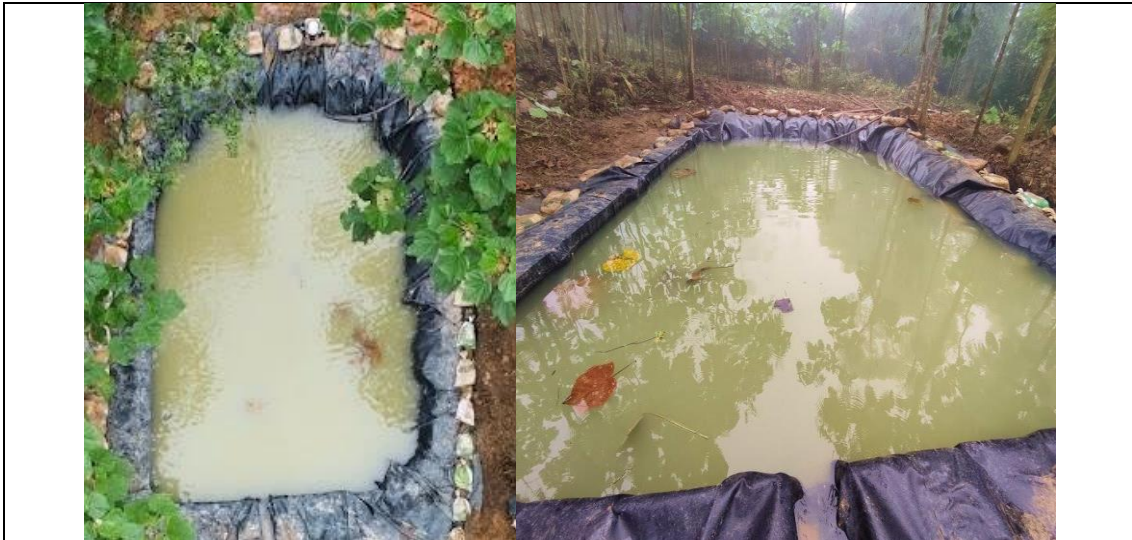
Fotografía 1.54. Registro fotográfico piscinas de sedimentación.
