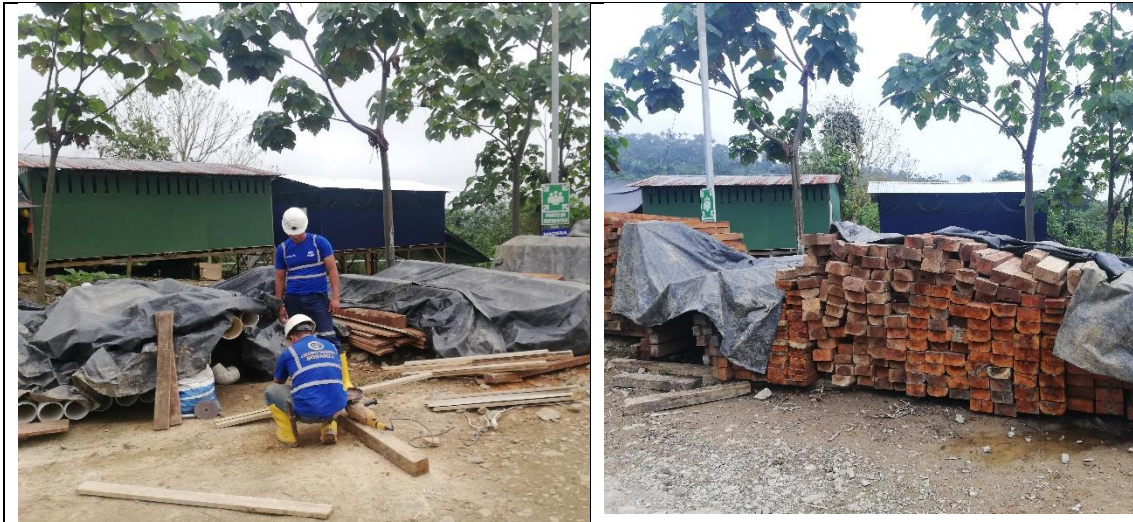
Fotografía 1.43. Acopio de madera, Concesión minera Leliatere.
