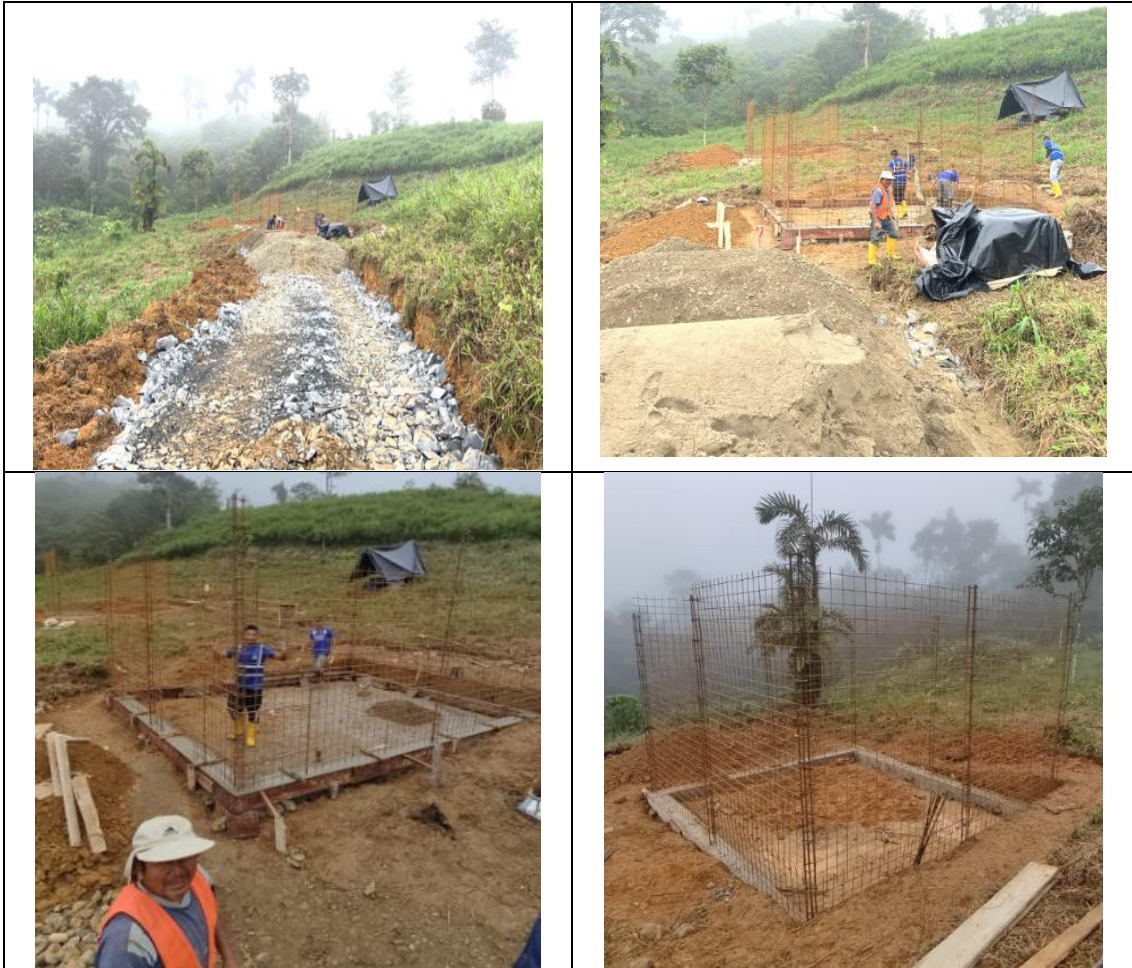
Fotografía 1.45. Polvorín, Concesión minera Leliatere.
